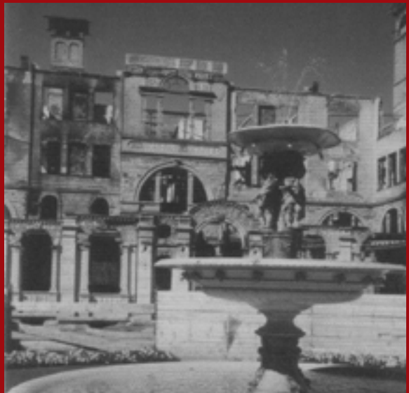
Friedrich Dürrenmatt und Charlotte Kerr fotografierten die noch immer imposante Ruine des 1989 abgebrannten, traditionsreichen Kurhotels Waldhaus Volpera.
